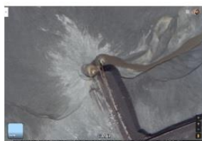
Жидкая (труба оборотной воды)
